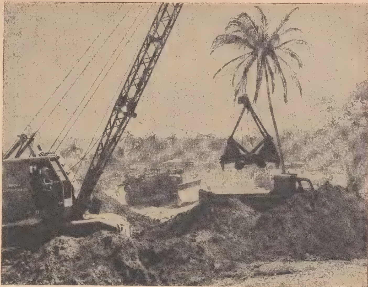
En esta escena de la producción guerrera, "Romance de los Siete Mares", en la que aparecen John Wayne, Dennis O'Keefe y Susan Hayward, en primera fila, vemos a los ingenieros de marina reconstruyendo el campo de aterrizaje que los bombardeos destruyeron.
